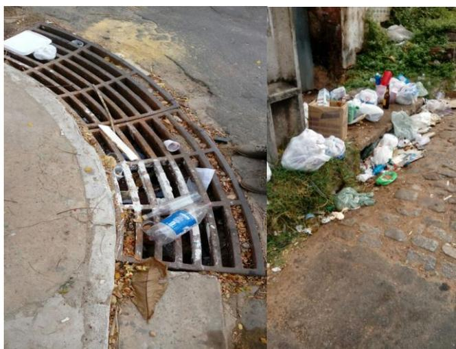
**Figura 18- Pontos de drenagem na parte baixa da fábrica próximo ao Mercado Central bloqueados pelo lixo.**
