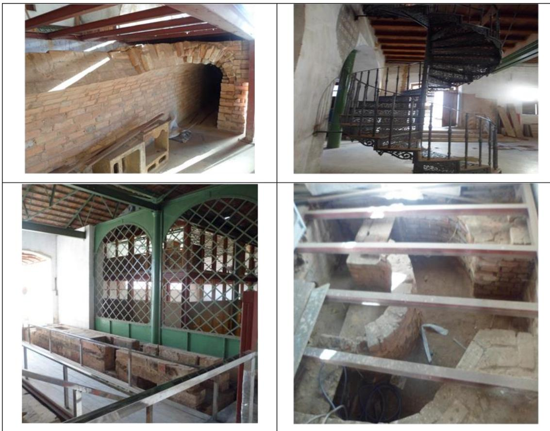
**Figura 3- Achados durante a escavação: parte da chaminé, escada helicoidal (restaurada), bases de motores**
